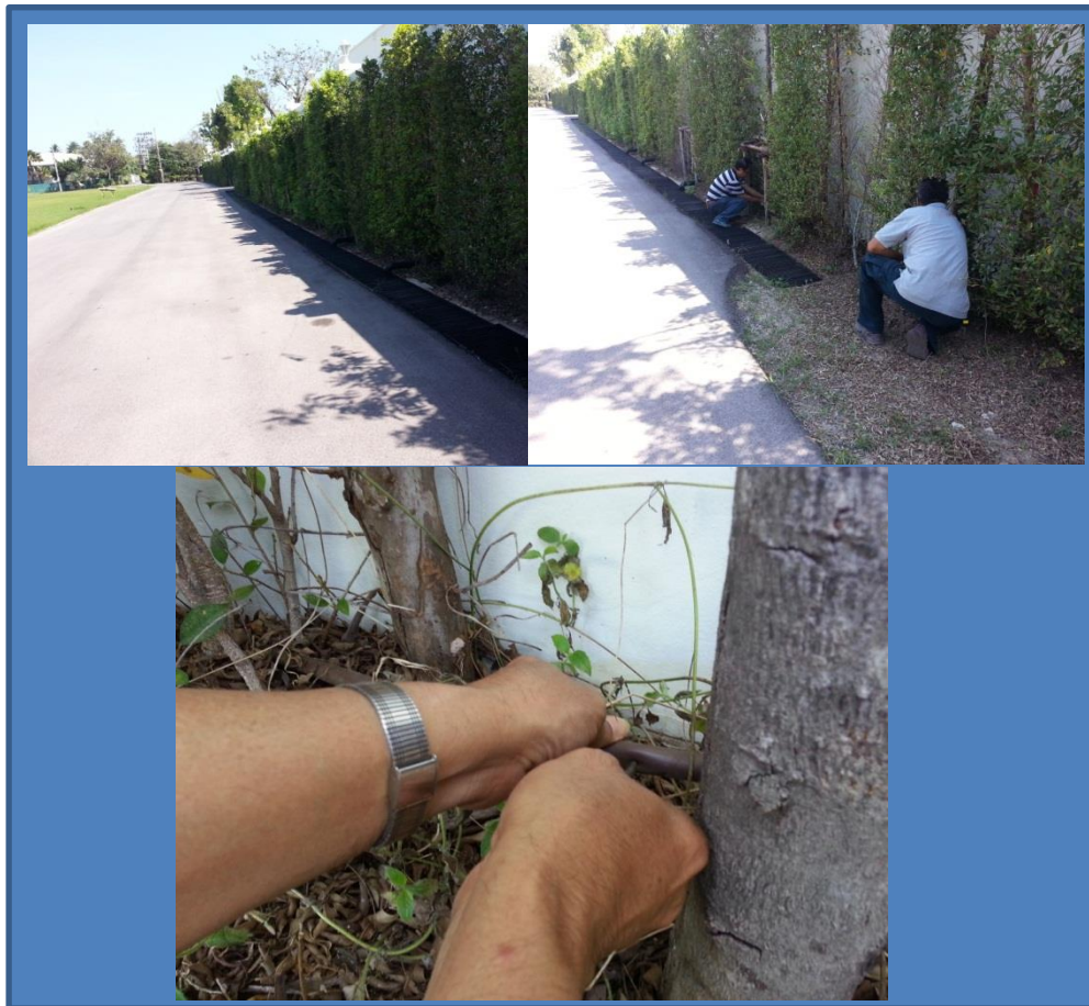
ภาพที่ ๘ การเจาะท่อระบายน้ำหยดบริเวณโคนต้นบอนนาคบริเวณแนวกำแพงเขตพระตำหนัก GATEY HOUSEY พระราชวังไกลกังวล
