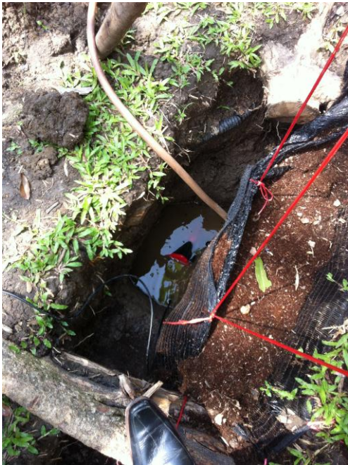
ภาพที่ ๒๓ สูบน้ำที่ท่วมขังโดยใช้เครื่องสูบน้ำขนาดเล็ก
