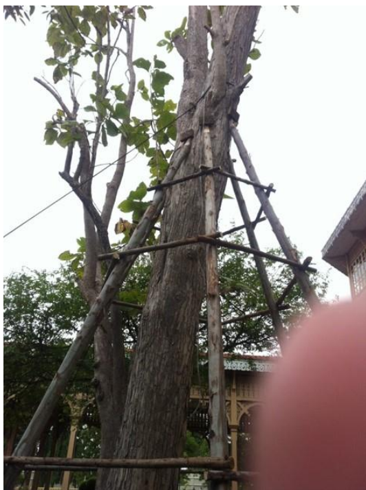
ภาพที่ ๑๓ ติดตั้งไม้ค้ำยัน
