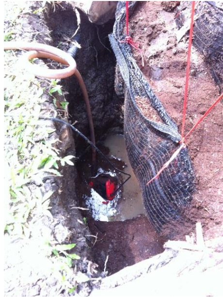
ภาพที่ ๑๘ สูบน้ำที่ท่วมขังโดยใช้เครื่องสูบน้ำขนาดเล็ก
